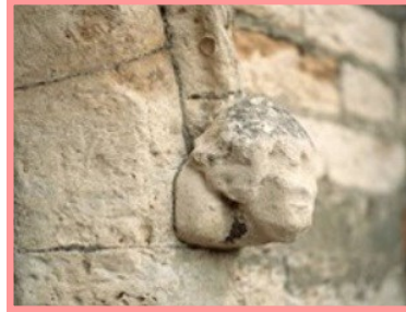
Sculpture au colisée à Rome qui s'érode à cause du vent et des pluies acides
